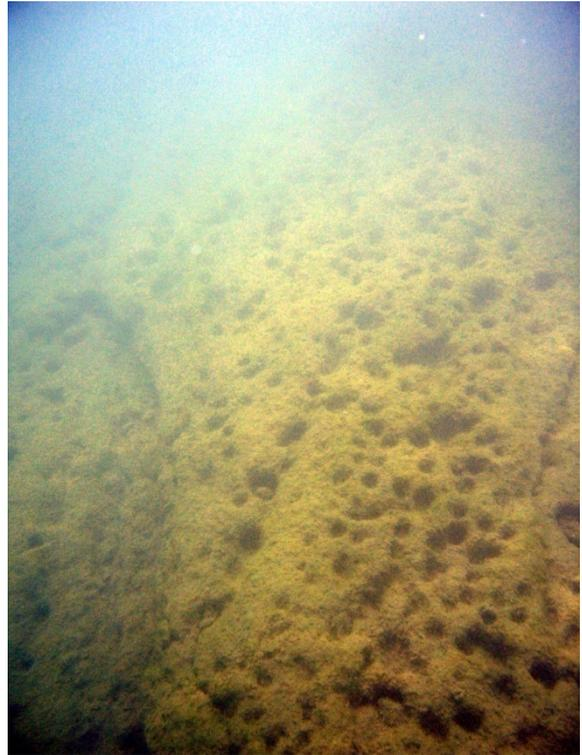
Detailfotos der schalenförmigen Vertiefungen beim Signalsockel
